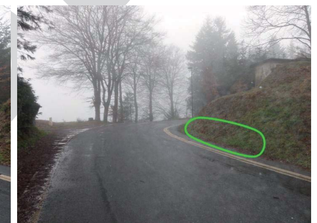
Photos 4 & 5 : Le lampadaire devra certainement être déposé pour le passage des pales, et il se peut qu'il faille rogner un peu la terre dans l'intérieur du virage pour permettre le passage de ces dernières.
