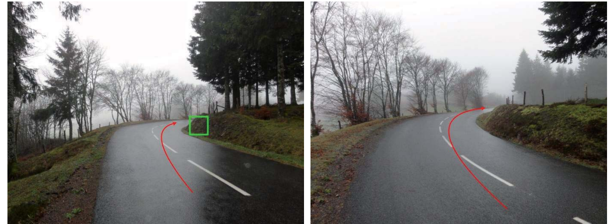
Photos 17 & 18 : L'intérieur du virage doit être repris pour augmenter le rayon de courbure.
