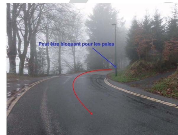
Photos 4 & 5 : Le lampadaire devra certainement être déposé pour le passage des pales, et il se peut qu'il faille rogner un peu la terre dans l'intérieur du virage pour permettre le passage de ces dernières.
