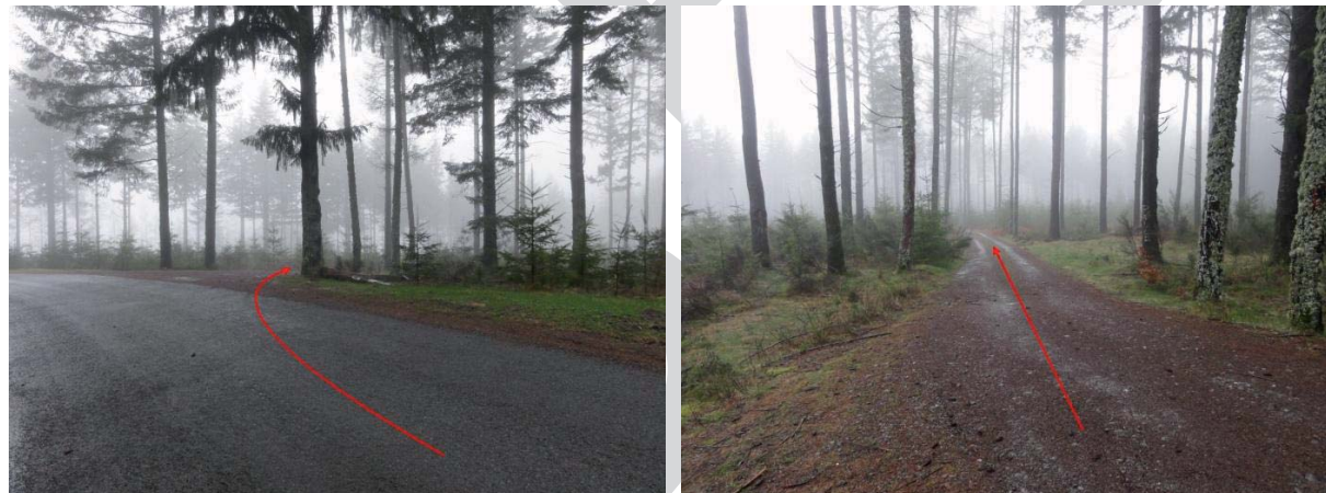
Photos 24 & 25 : Pour accéder au chemin d'accès vers les machines, il faut couper les arbres, et créer le rayon de courbure aux normes du constructeur.
