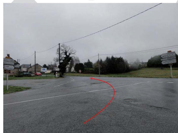
Photos 2 & 3 : Bifurcation sur la D 16. Il faut enlever soit l'arbre soit le poteau pour permettre aux transports de tourner, car les deux sont presque en face l'un de l'autre.
