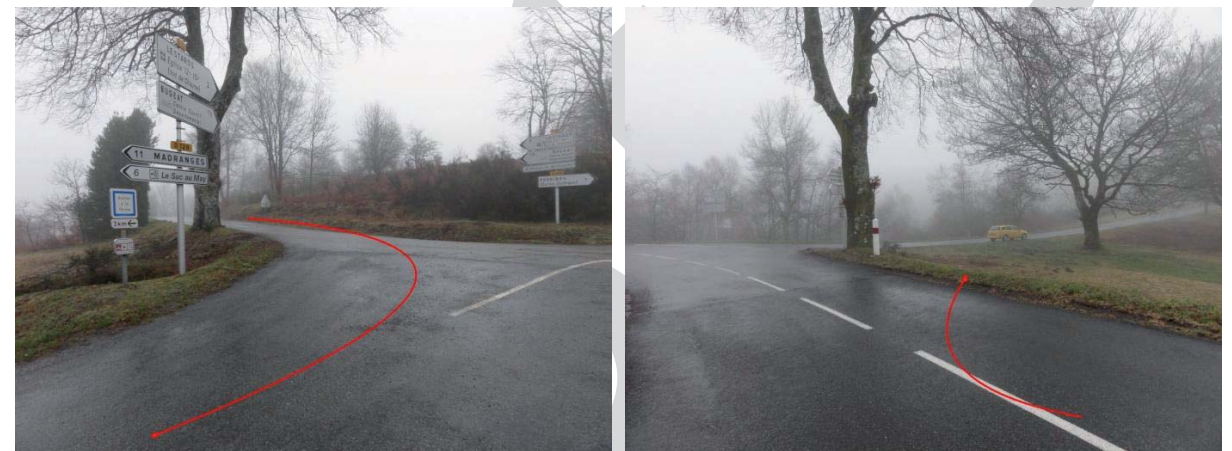
Photos 17 & 18 : L'intérieur du virage doit être repris pour augmenter le rayon de courbure.
